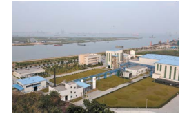
Теплообменный аппарат охлаждения серной кислоты, Chongqing, КНР стр.57
